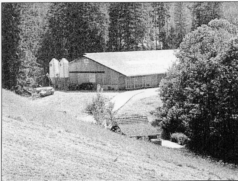
Der neue Winterschafstall, von der Wanderhütte aus gesehen.
