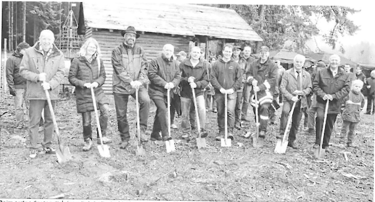
Beim ersten Spatenstich (von links) die Architekten Heinz und Carmen Feuchter, Kämmerer Günther Muth, Bauamtsleiter Erich Günter, Roif Kilgus von der Firma Seegerbau, Marco Eberhardt, Vorsitzender der Dorfgemeinschaft Schömberg, Abteilungskommandant Uli Armbruster, Ortsvorsteher Kurt Winter und Manfred Hauser, stellvertretender Bürgermeister Foto: Schwark
