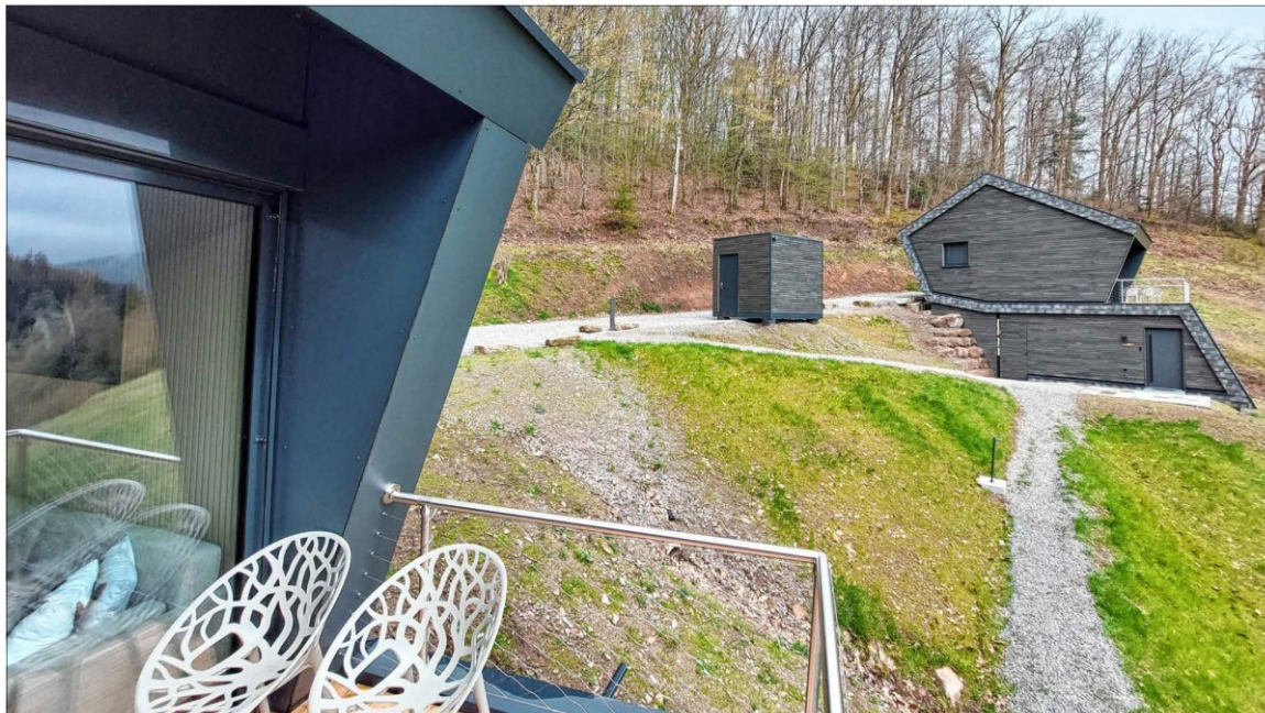
Von außen sind die Smart Lodges am Hang kompakt, innen wird der Platz möglichst effizient genutzt.
