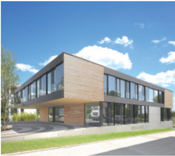
Fotos Architekturfotografie Roland Halbe, Stuttgart
