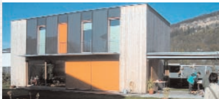
Bild 12 – Passivhaus-Einfamilienwohnhaus mit Nachverdichtungsmöglichkeit in A-Wolfurt, Architekt Hermann Kaufmann
