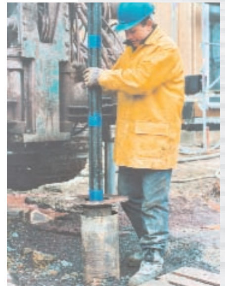
Bild 2: Einbringung von Erdsonden in 150 m tiefe Bohrlöcher
