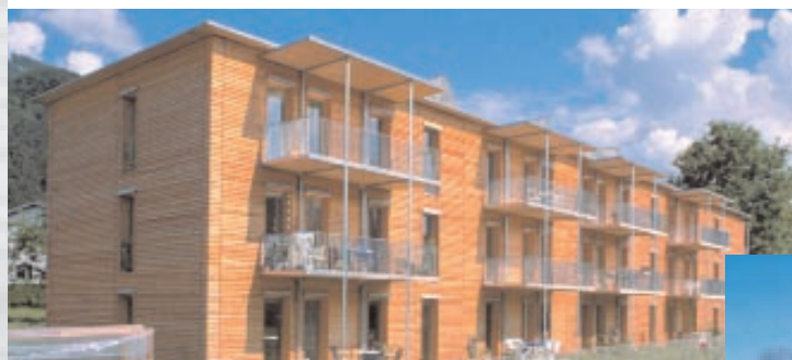
Bild 9 – Das erste Passivhaus in vorgefertigter Holzbauweise im Geschosswohnbau: „Ölz-bündt“ in A Dornbirn, Architekt Hermann Kaufmann
