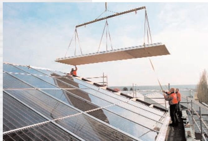
Bild 5: Installation von Solardächern für ein solares Nahwärme- system
