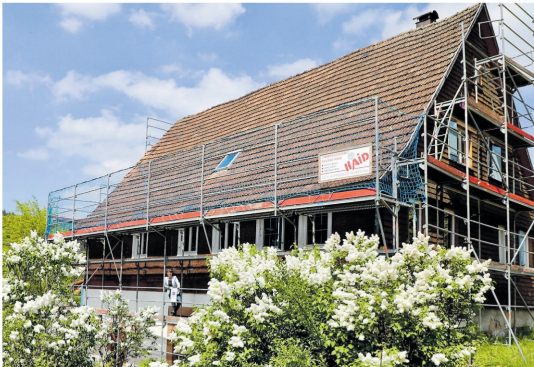
Altes bewahren und Neues gestalten – nach diesem Motto wird das Leibgedinghaus des Bachbauernhofs in Ehlenbogen saniert.
